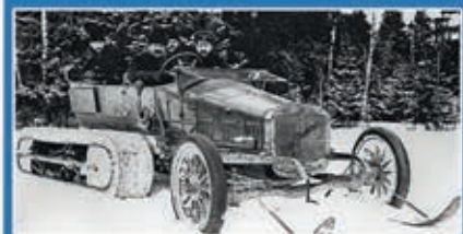
Отечественный автомобиль — полугусеничная машина на шасси «Руссо-Балт С24-30»
